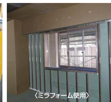
単体後貼り工法
