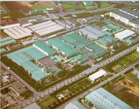
鹿沼第一工場
