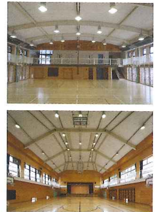
施工例：学校体育館
